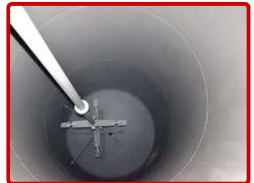
Barvano z debeloslojno kerami no barvo
