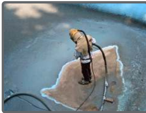
Peskanje znotraj rezervoarja
